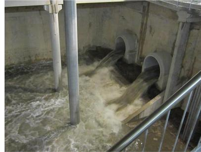
El depósito, con una capacidad de 60.000 m<sup>3</sup> (20 piscinas olímpicas), intercepta y almacena el agua recogida por las redes de alcantarillado, para enviarla posteriormente a la EDAR de forma progresiva, evitando así esos desbordamientos y episodios de contaminación.
