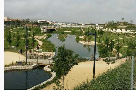
Obra de ingeniería y paisajística que da respuesta al problema de una zona próxima sujeta a frecuentes inundaciones. El parque se articula alrededor de un estanque central permanente alimentado con agua regenerada, rodeado de plantas y árboles propios del entorno mediterráneo, que han atraído a gran variedad de aves.
